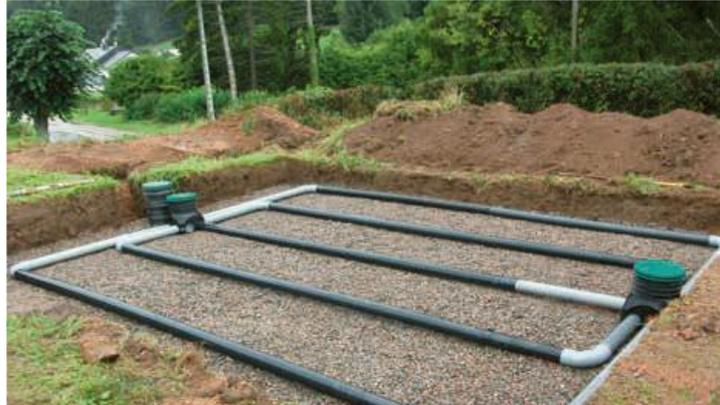
Prétraitement + Traitement en reconstituant un massif de sable (sol artificiel)
