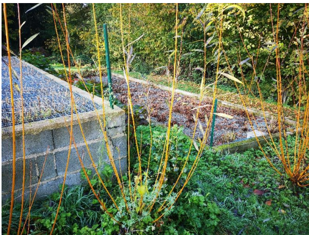
Phyto-épuration sur 2 niveaux
